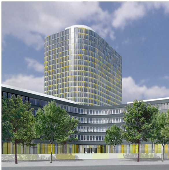
ADAC-Zentrale München; Foto Züblin
