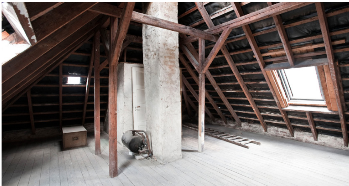
ungenutzter Dachboden; alle Fotos Velux
