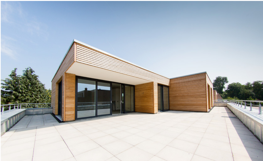
Penthaus dachterasse; alle Fotos Büter
