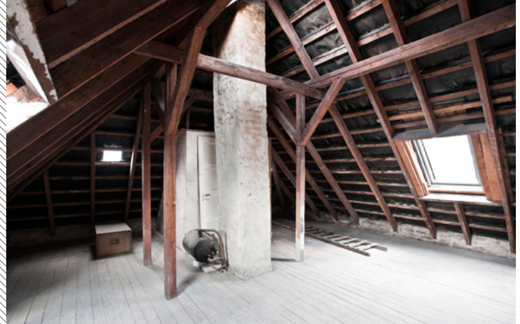
ungenutzter Dachboden; Foto Velux
