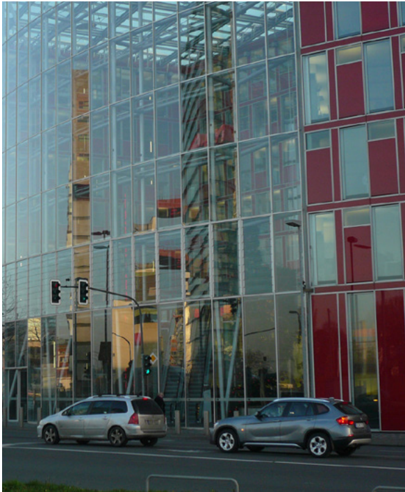
Lärmschutz Glasfassade; Foto capricorn
