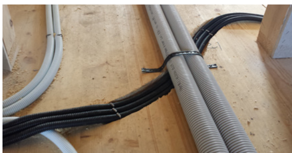
Die Anschlüsse für die Lüftungsleitungen wurden im Bad so vorbereitet, dass die Abluft-Wärmepumpe direkt darunter aufgestellt werden kann.
