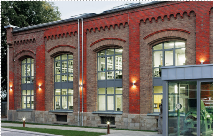
Neben dem Bürokomplex bietet die Pumpenhalle als Kultur- und Seminarforum Platz für öffentliche Veranstaltungen.
