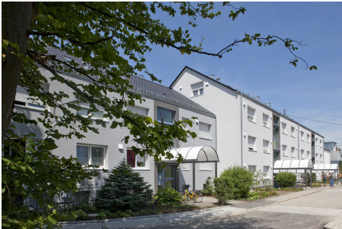
Energetische Sanierung bei der SGF Siedlungsgenossenschaft
