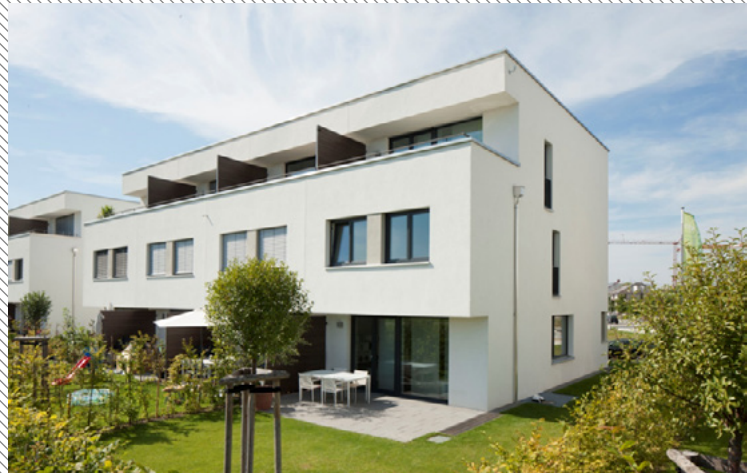
Geradliniger Vierspänner in der Wohnsiedlung „ecologis“ Walldorf: Foto: Tecalor / Johannes Vogt
