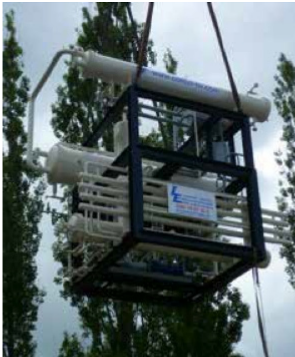
Mitte Oktober wurde die Gasabsorptionspumpe eingebaut
