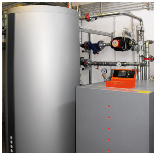
Viessmann Wärmepumpen-Anlage mit Solar-Eisspeicher
