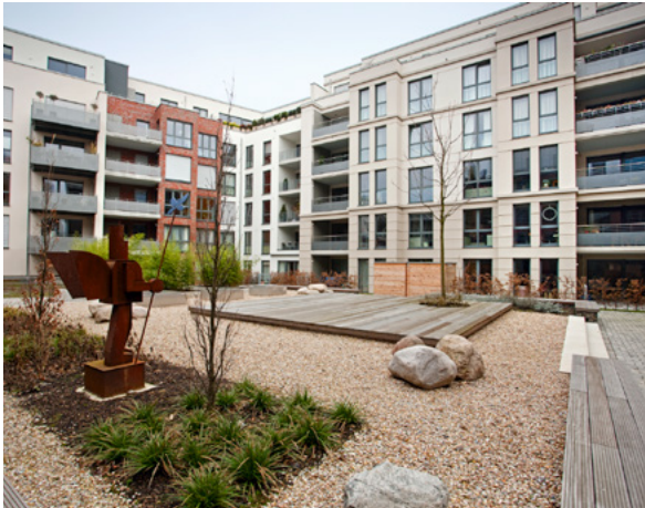
Ideale Bodenverhältnisse machen den effektiven Einsatz von Wasser/Wasser-Wärmepumpen möglich.
