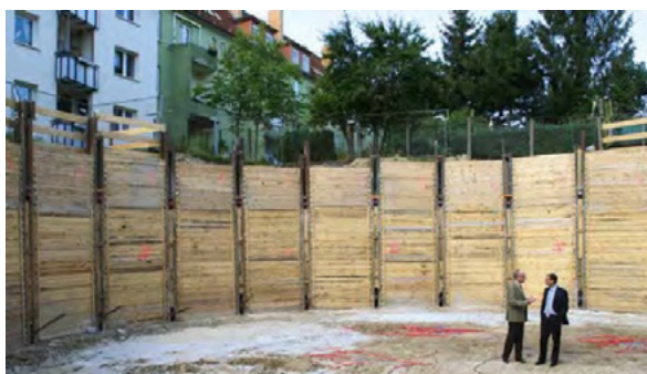
Der Eisspeicher im Bau
