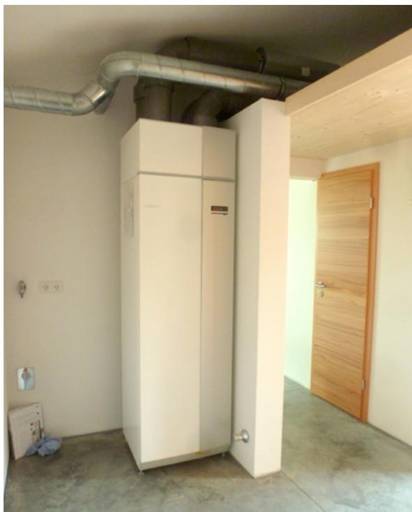
Die kompakte Heizungs-, Brauchwasser- und Lüftungszentrale Nibe F470 nimmt aufgrund der kompakten Abmessungen von nur 600 x 615 x 2100 mm (BxTxH) wenig Platz in Anspruch. Dank der guten Optik lässt sich diese Wärmepumpe sehr einfach im Haus integrieren.
