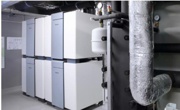
In den Kellern der Mehrfamilienhäuser sind vier kaskadierte Wasser/Wasser-Wärmepumpen von Stiebel Eltron angebracht. Jeweils zwei der Geräte stehen übereinander, um Platz zu sparen.
