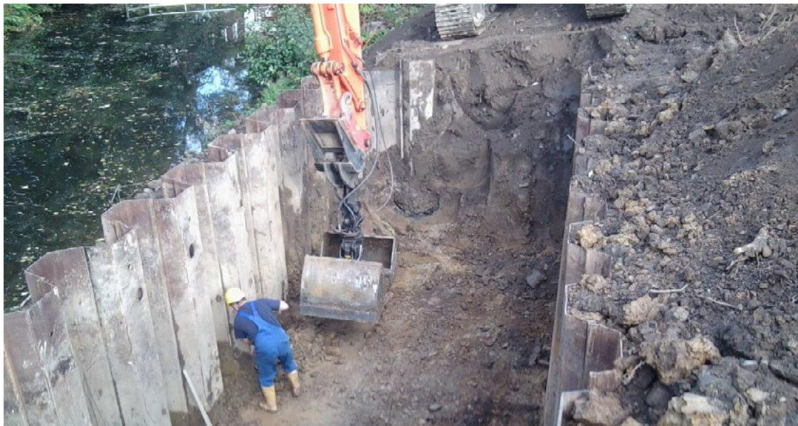
Neubau Straßenbrücke Westumgehung; Stadt Olpe
