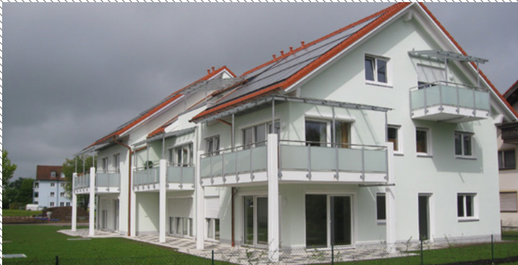
Solarhaus Freilassing: Mauerziegel „Unipor W07 Coriso“ mit einem Wärmedurchgangswert 0,18 W/(m 2 K); Foto Leipfinger-Bader
