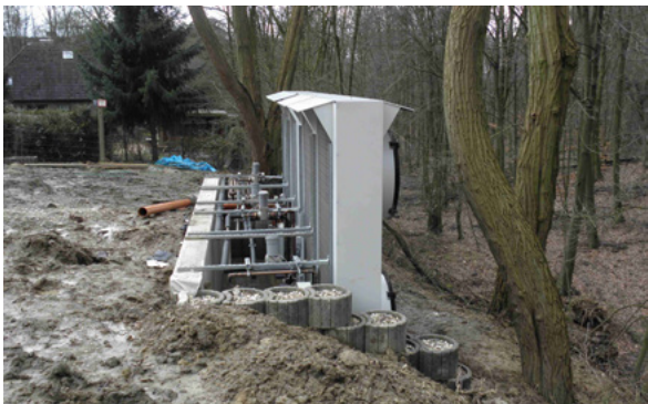
Verdampfer während der Bauphase. 4 Ventilatoren, mit fast 1 Meter Durchmesser, treiben die Außenluft über die Verdampferfläche.
