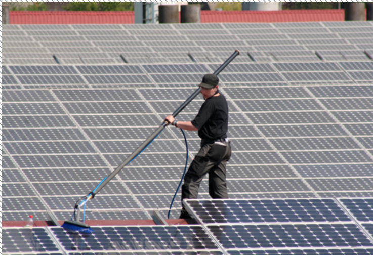
Mit „weichem Wasser“ wird chemiefrei gereinigt, damit keine schädlichen Abwässer in die Umwelt gelangen; Foto Niederberger Gruppe
