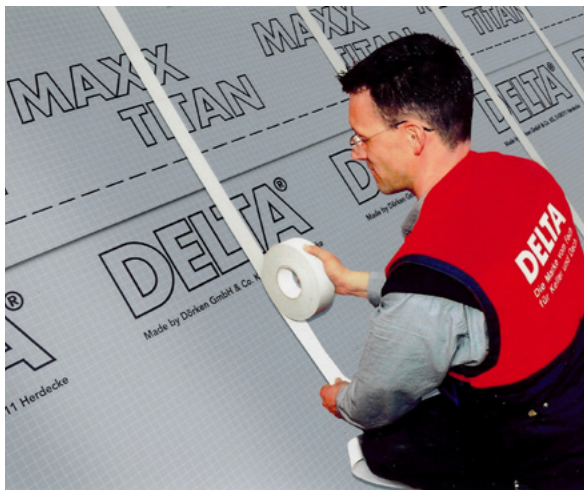
Stoßabklebung luftdicht; Foto Dörken
