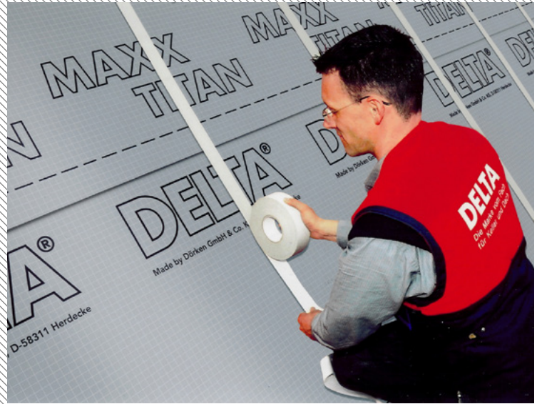
Stoßabklebung luftdicht; Foto Dörken
