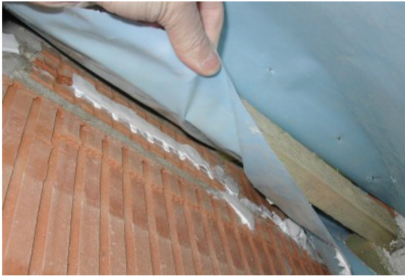
Wand-Dach-Anschluss; Foto kro
