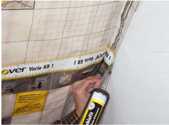
Randverklebung Folie-Mauerwerk; Foto Isover
