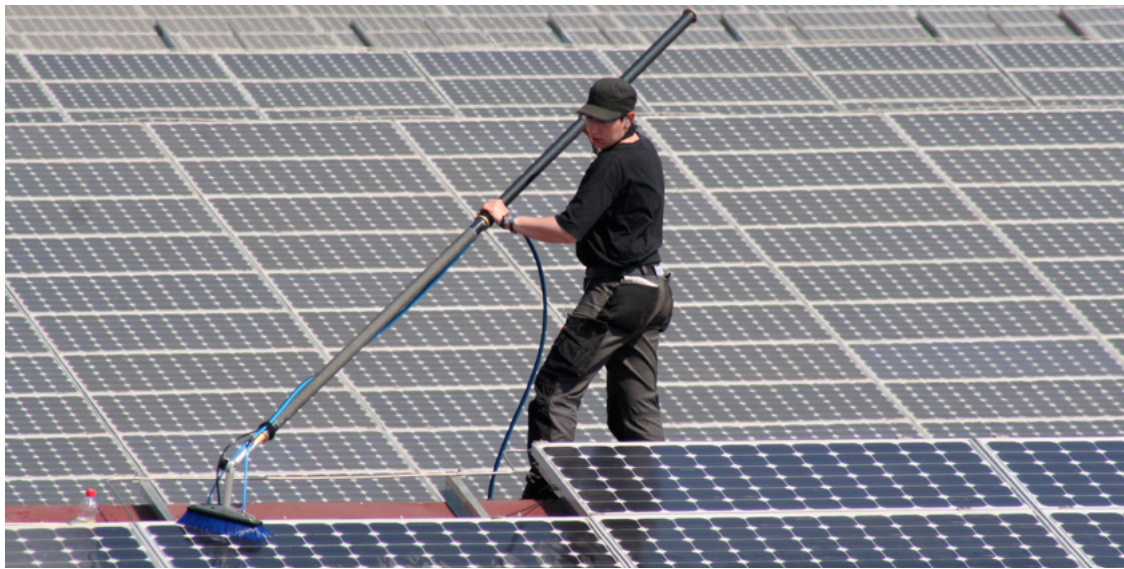
Solaranlage reinigen; Foto Niederberger
