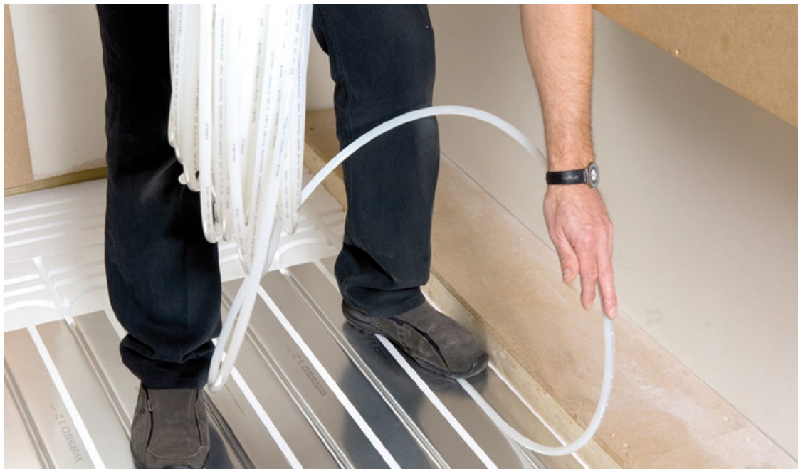
Siccus-FBH-Verlegung; Foto Uponor
