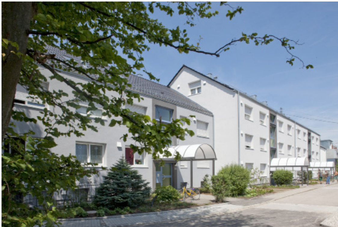
Energetische Sanierung bei der SGF Siedlungsgenossenschaft
