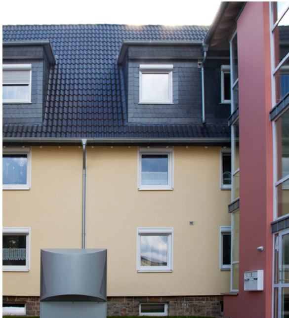
Strassenansicht Mehrfamilienhaus Hemer
