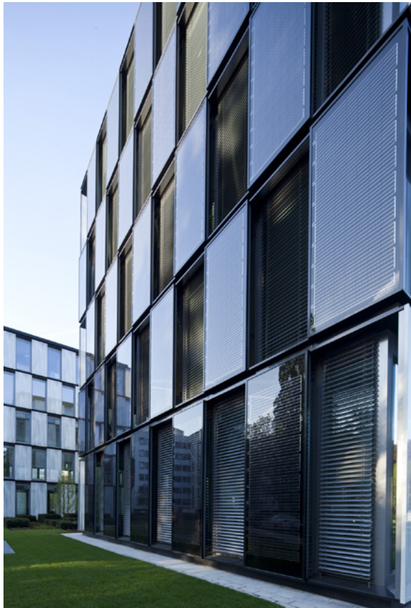
Solarfassade; Foto rehfeld fotografie
