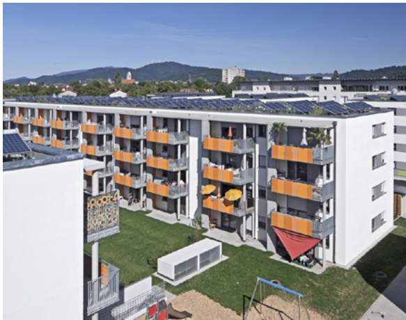
Solaranlagen auf dem Dach
