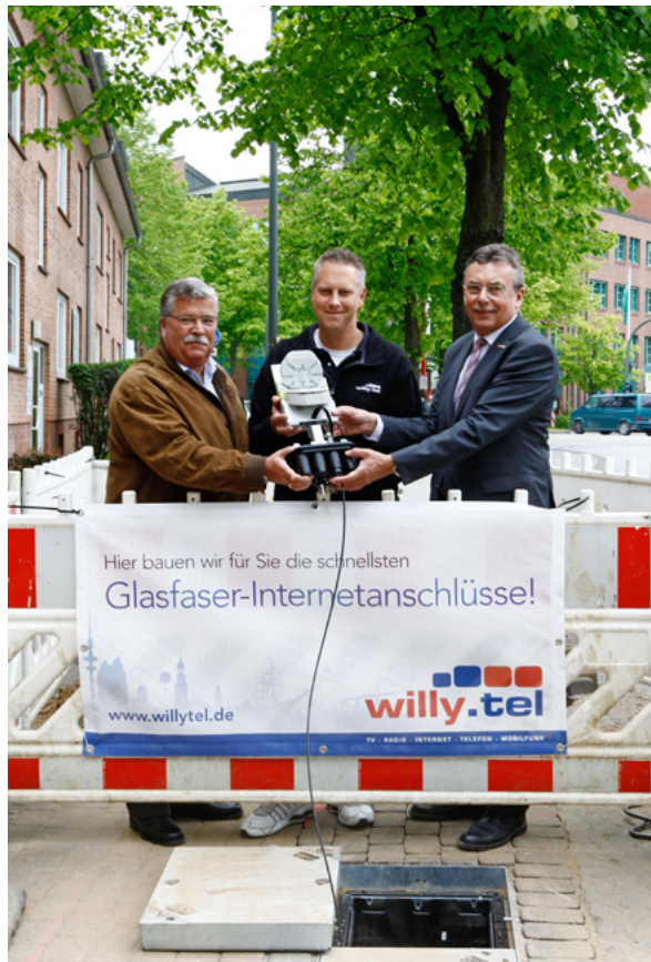
Glasfaserverlegung; Foto Carlos Kella
