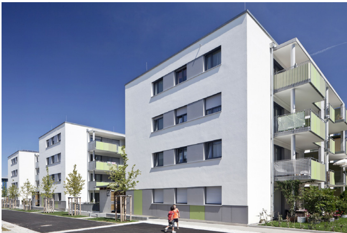
Ansicht Gesamtanlage; alle Fotos Ioeffelhardt
