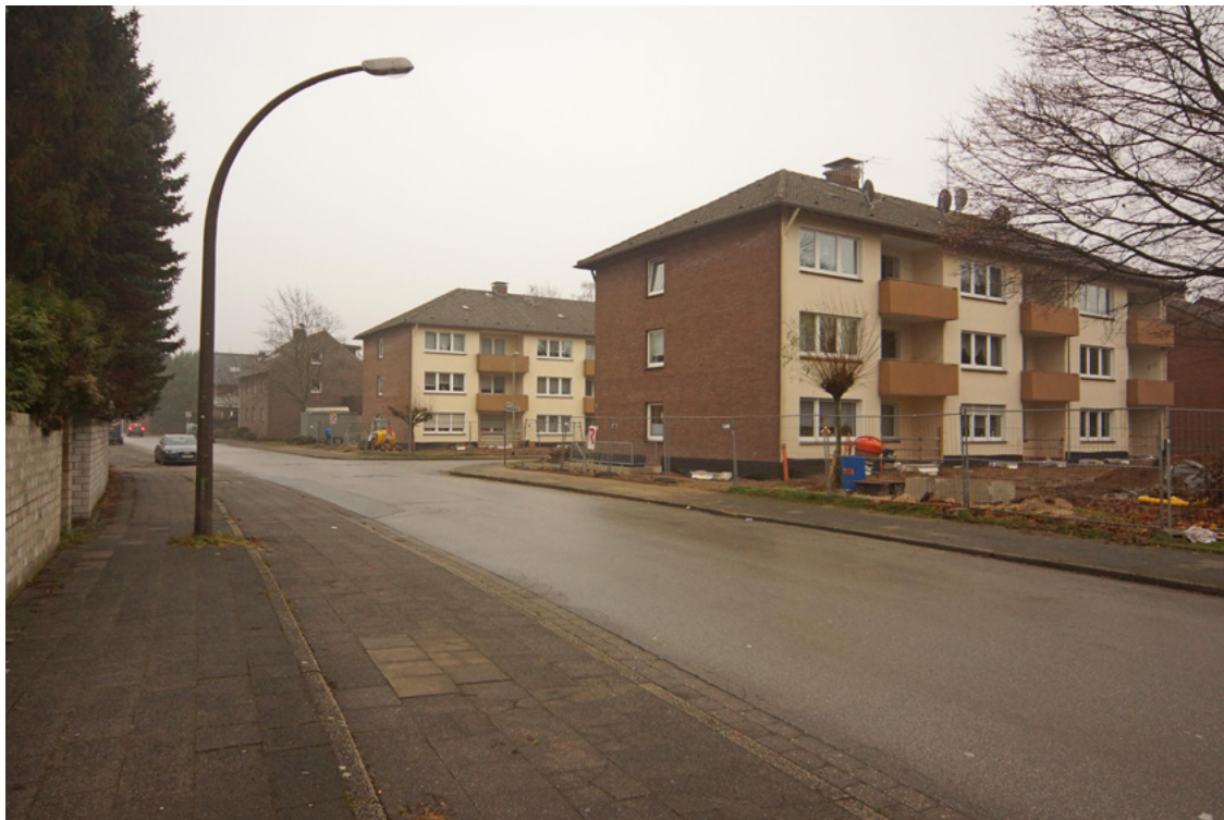
Häuser vor der Sanierung; alle Fotos ZimmerMeister Haus
