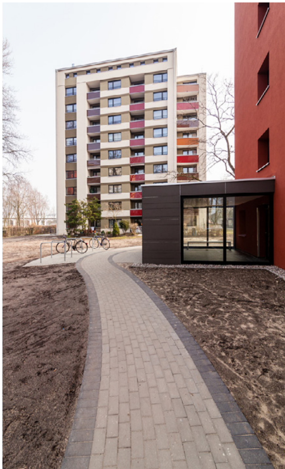
Barrierefreier Hauszugang; Foto Bauverein der Elbgemeinden eG
