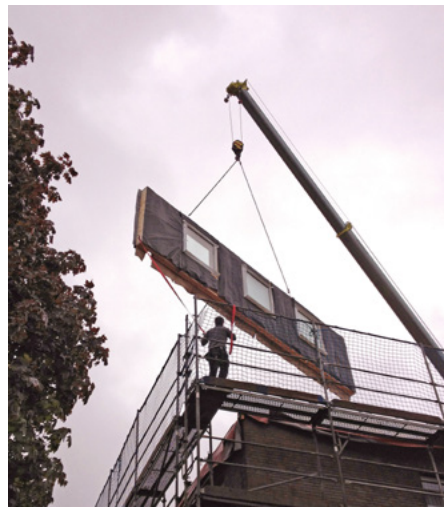
Montage der Fassadenelemente
