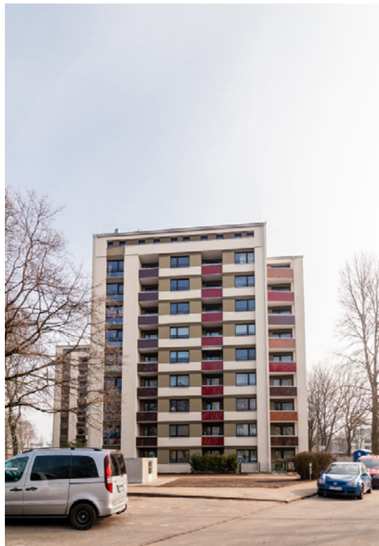
Sanierung, barrierefreier Eingangsbereich, Objektsanierung, Ansicht nach Sanierungen, alle Fotos Bauverein der Elbgemeinden eG
