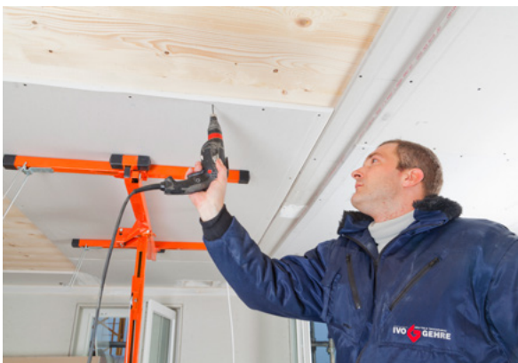
Deckenmontage; Foto Knauf
