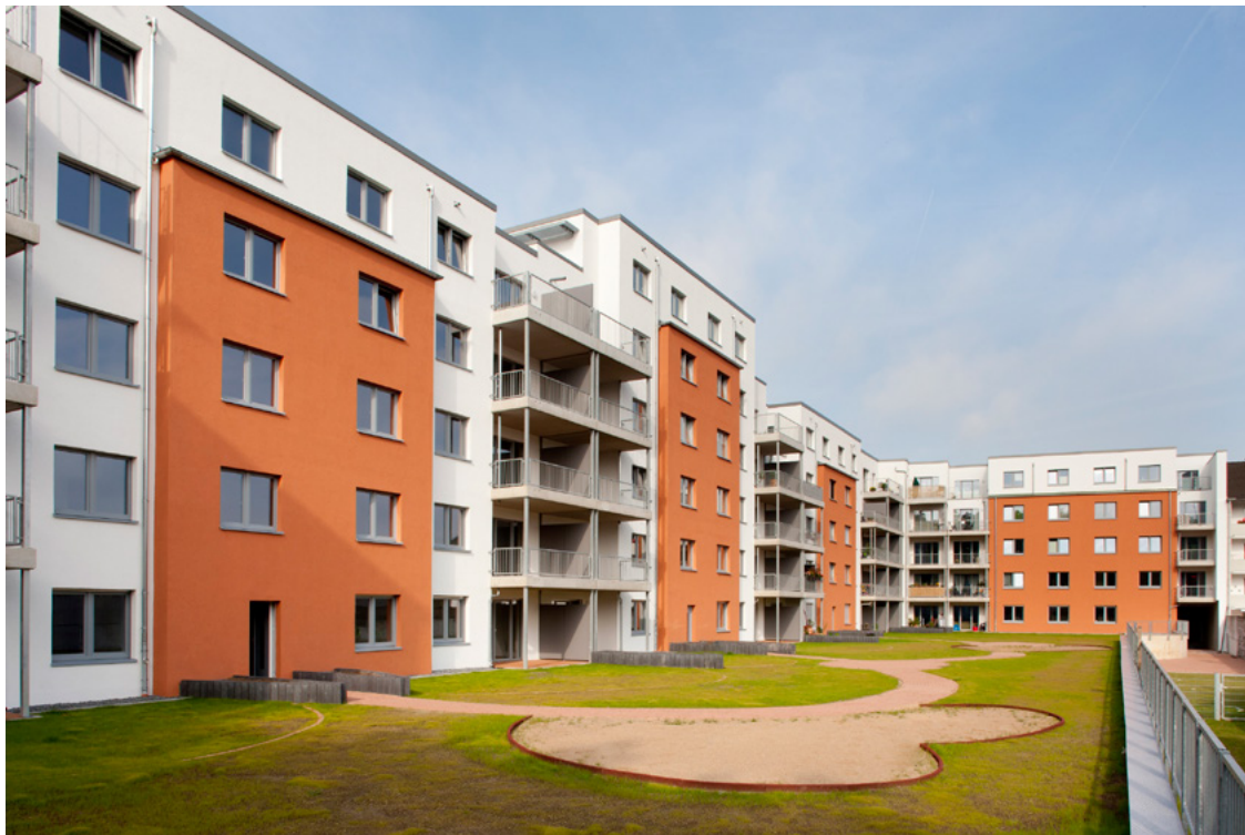
Saniertes Gebäudebereich; Foto Inoutic
