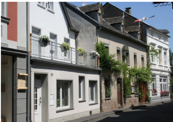
Hausfassaden; Foto Krolkiewicz
