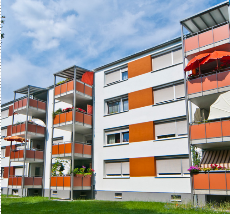
Ansicht Wohnanlage; Foto Knauf
