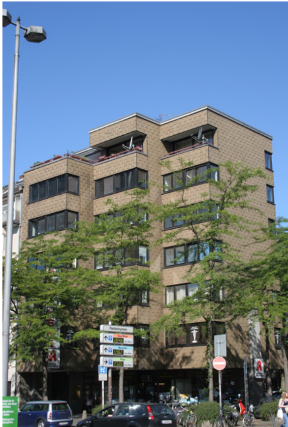
Vorhangfassade Faserzement; Foto Krolkiewicz
