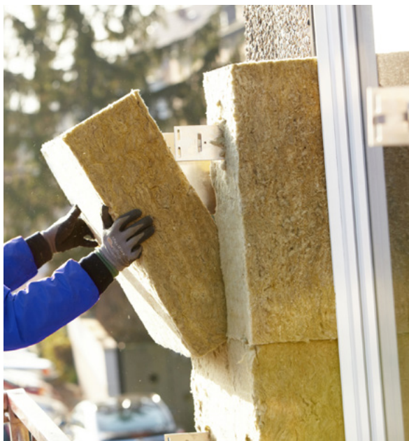
Brandriegel Mineralwolle; Foto Rockwool
