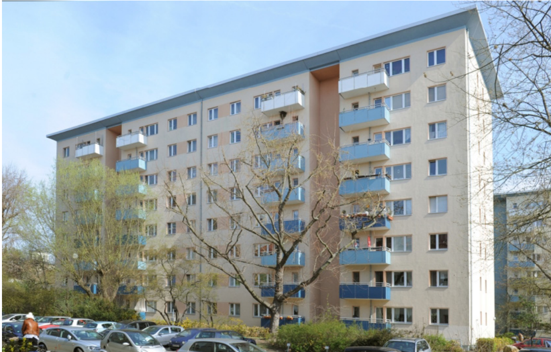
Und so sieht die Technologie im degewo Zukunftshaus
