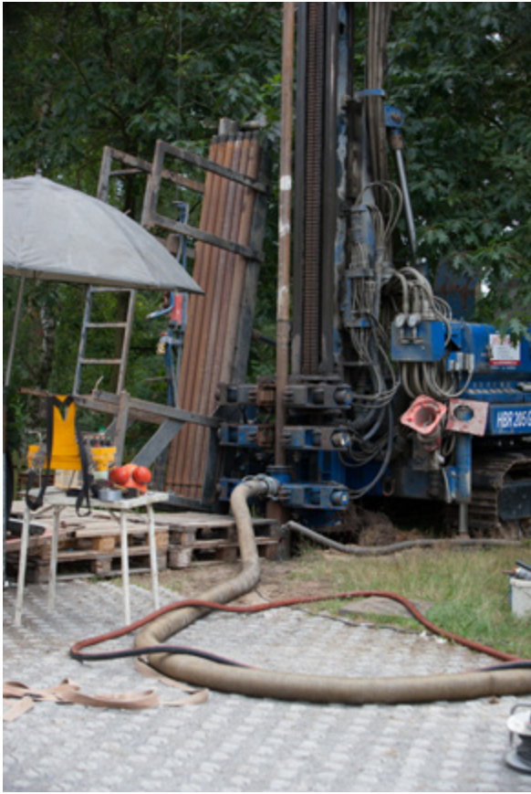
Bohrung für die Erdsonden der Wärmeversorgung; Foto DGI AG
