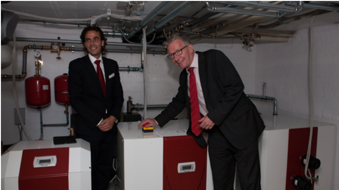
Celles OB Dirk-Ulrich Mende nimmt offiziell die Erdwärme Umstellung der Immobilien in Betrieb; Foto DGI AG
