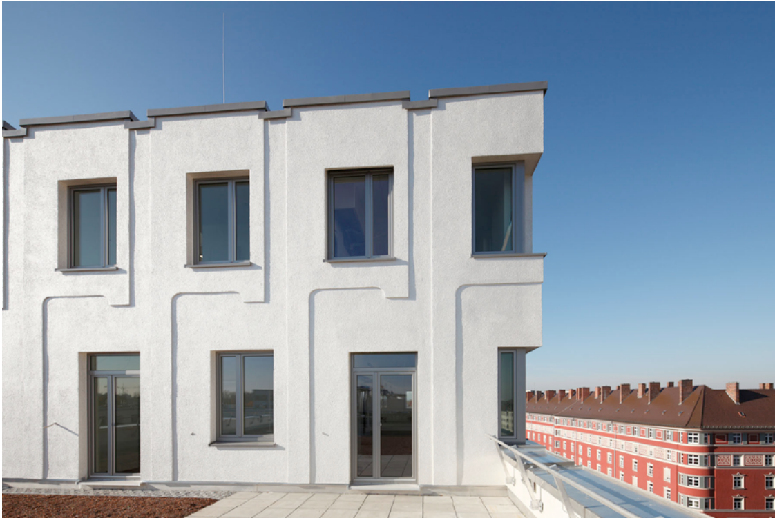
Technisch vorbildlich gelöst
