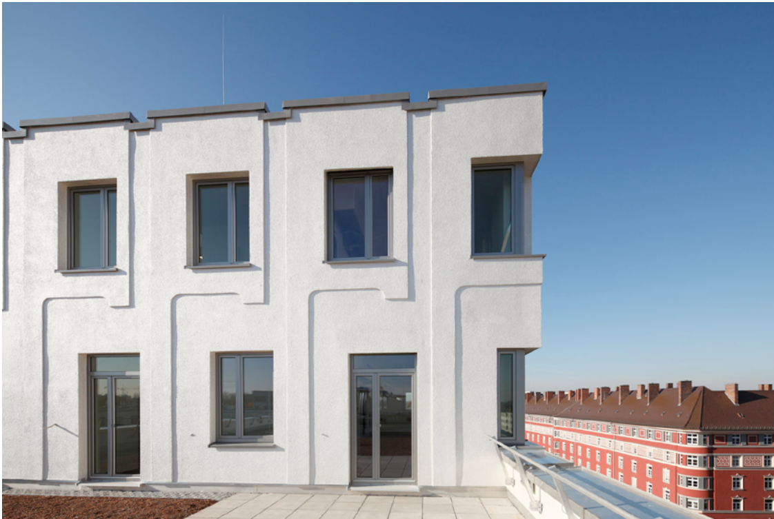
Technisch vorbildlich gelöst
