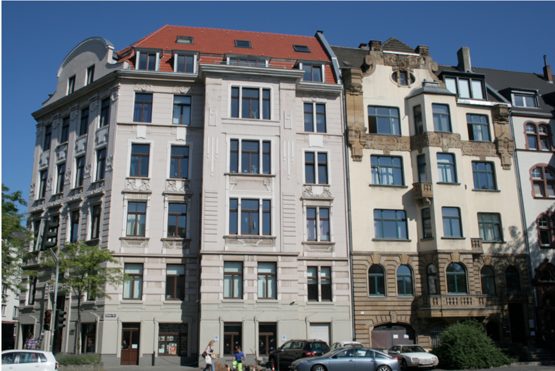
Stuckfassade saniert; Foto Krolkiewicz)
