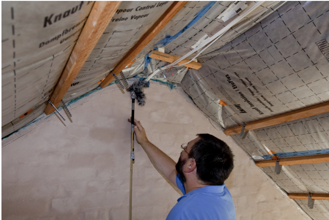
Luftdichte Kabelführung im Dachgeschoss
