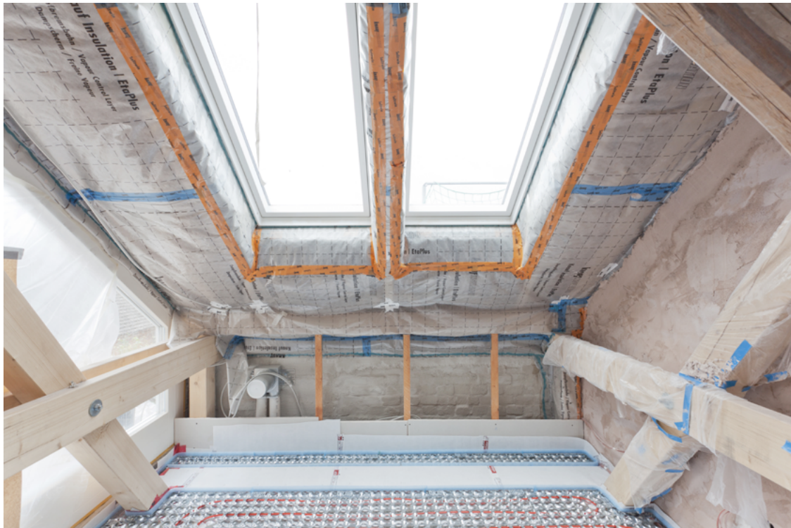
Dachfensteranschluß luftdicht
