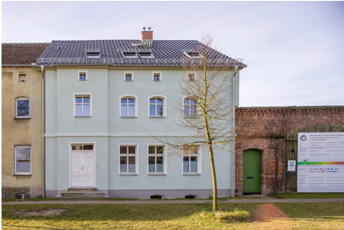
Ansicht nach Sanierung
