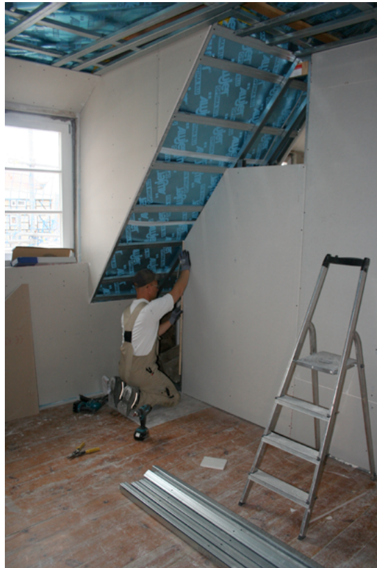
Perimeterdämmung Polystyro und Bekleidung Dachschräge; Foto Krolkiewicz
