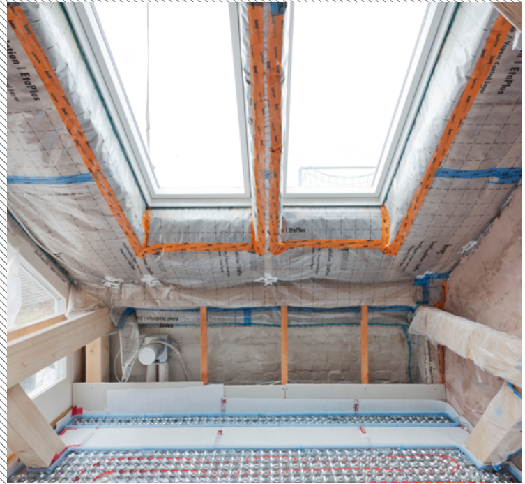
Dachanschluß; Foto Knauf
