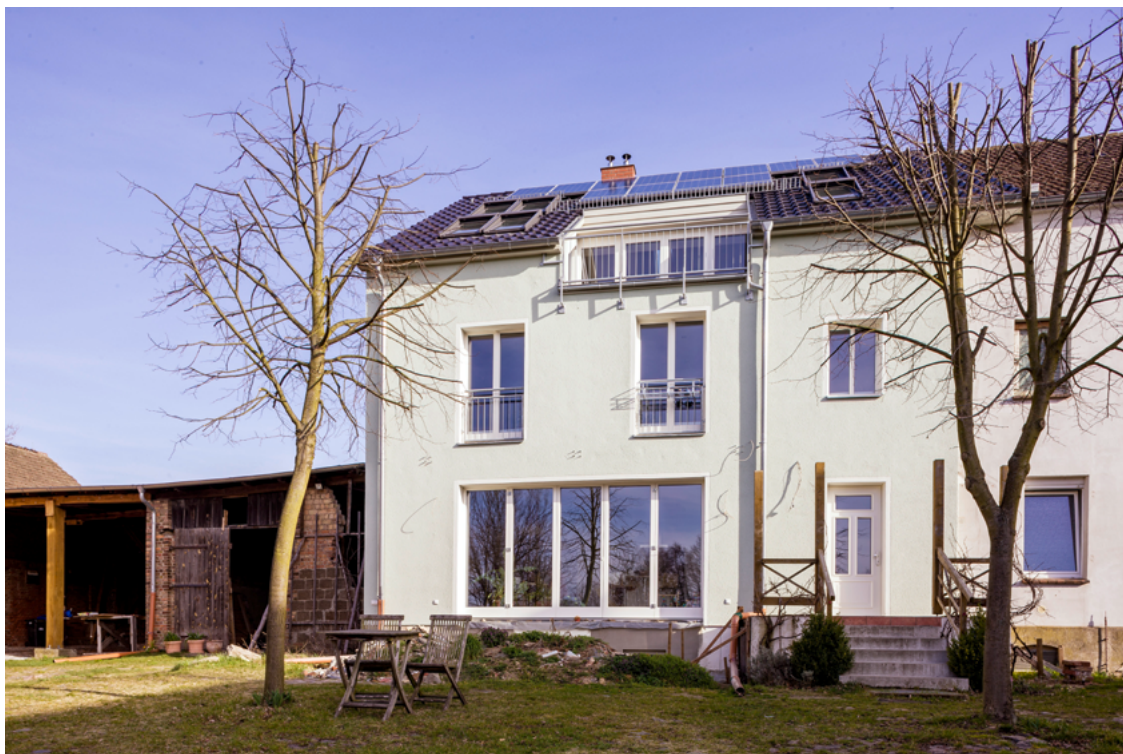
Gartenseite mit neuer Fassade; alle Fotos Knauf
