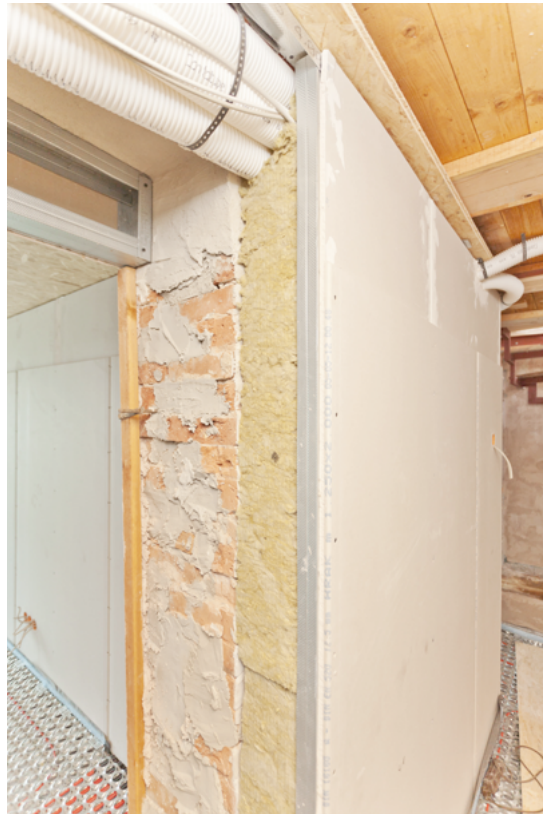
Aufbringung Innenputz und Detail Türanschluß mit Leitungsführung
