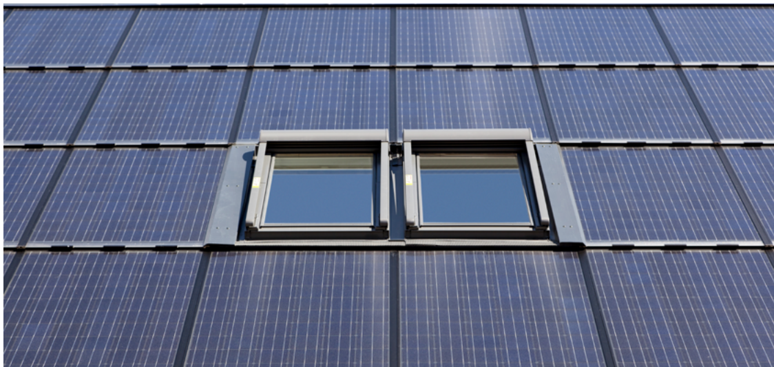
Dachfenster eingebunden; Foto Solarawtt
