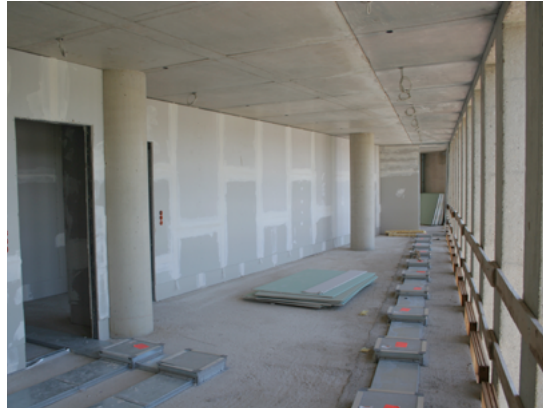
links: Gipskartonwand unbehandelt; rechts: Innenwand Büroereich; beide Fotos Krolkiewicz
