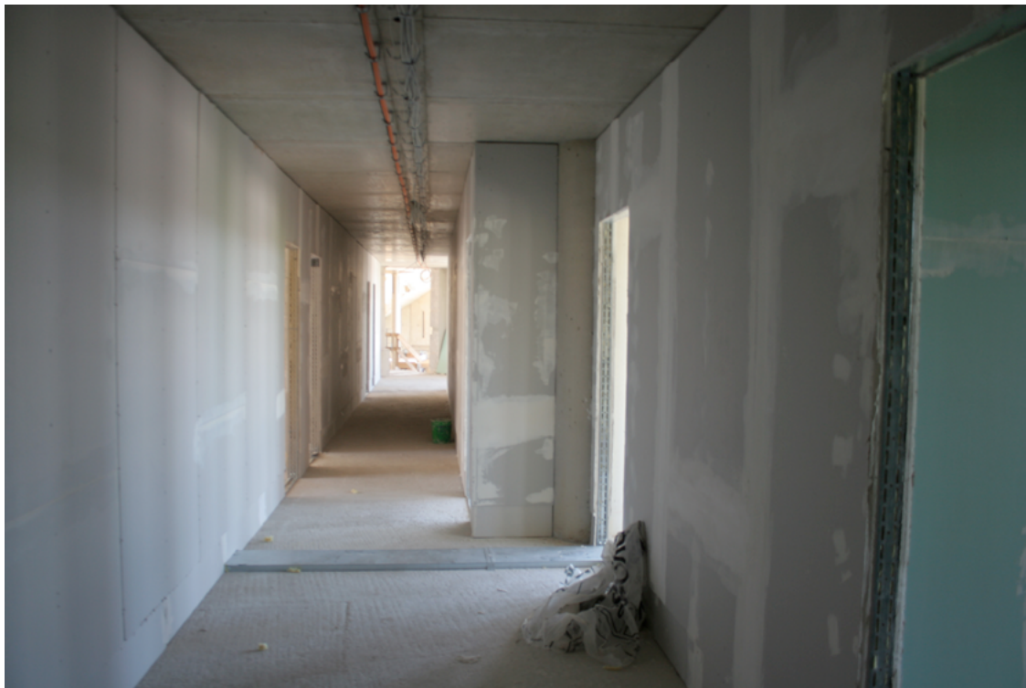
Innenausbau Flurbereich; Foto Krolkiewicz
