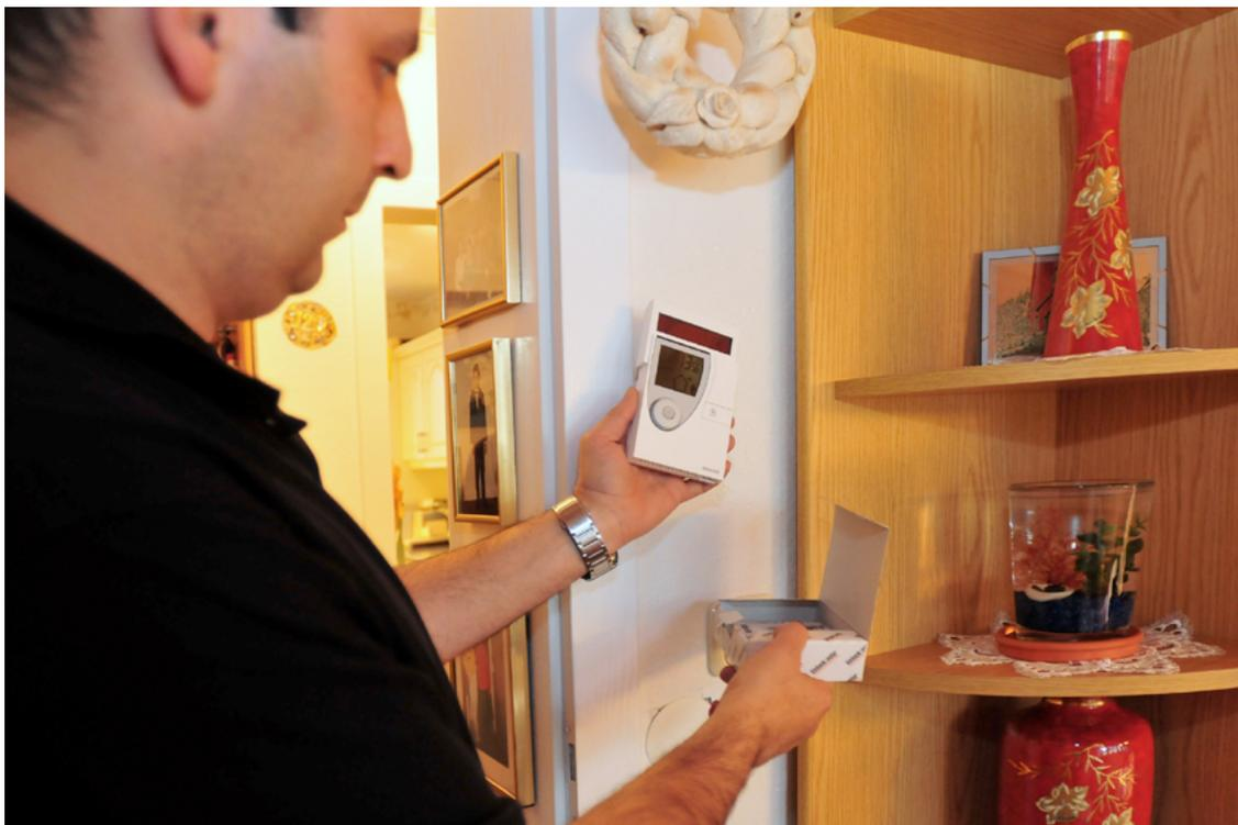
Der Raumsensor ist mit einer Präsenzerkennung ausgestattet, so dass in jedem einzelnen Zimmer die Komforttemperaturen bedarfsgerecht gesteuert werden – das spart bis zu 20 Prozent Heizenergie. (Fotos Kieback&Peter)
