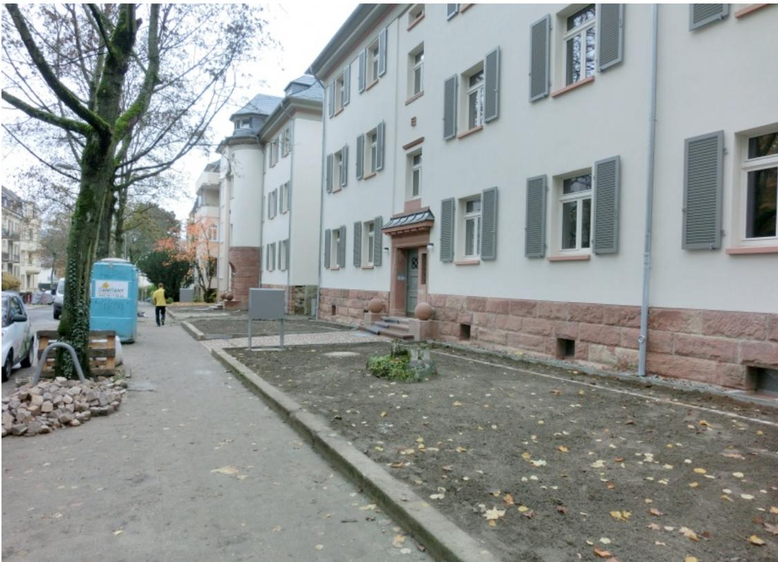
Bei den 1926 in Massivbauweise errichteten Wohngebäuden wurden die Grundrisse der Wohnungen an die heutigen Bedürfnisse angepasst und die Gesamtwohnfläche erhöht. Durch konsequente energetische Maßnahmen kann der Energieverbrauch erheblich gesenkt werden. Foto GWW
