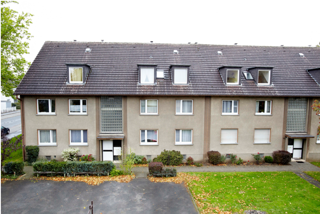
Ansicht vor der Sanierung
