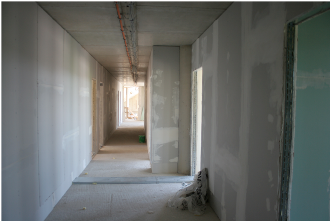
Innenausbau Flurbereich; Foto Krolkiewicz
