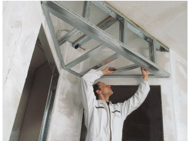
Ausbau Dachgeschoss; Foto Knauf
