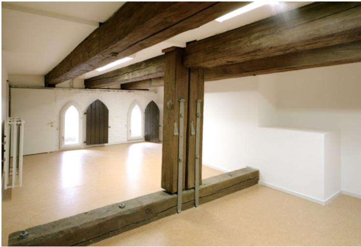
Altbausanierung; Foto Knauf
