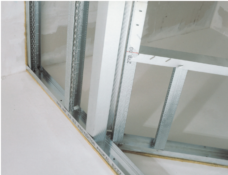
Altbausanierung; Foto Knauf
