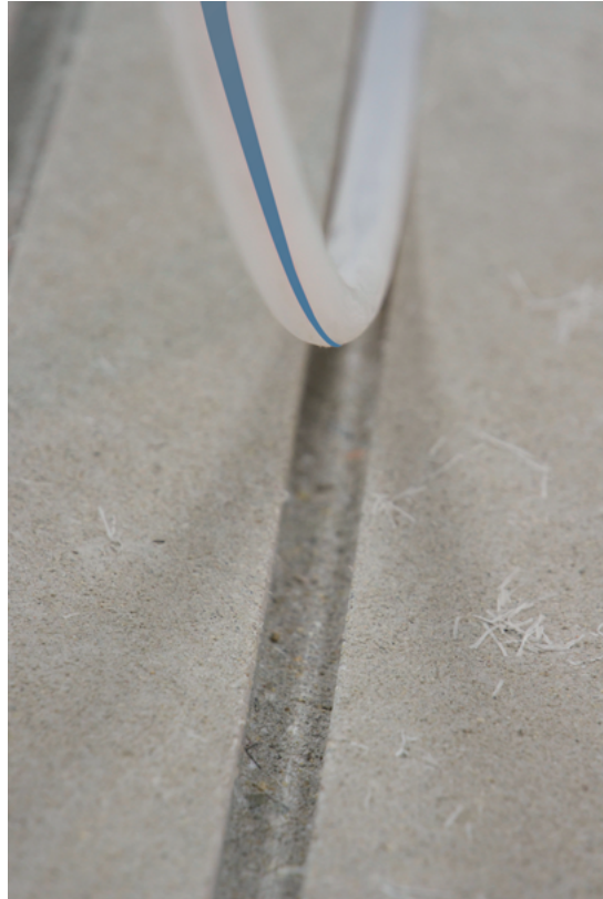
Zent-Frenger Frästechnik und Verlegung der Heizungsrohre
