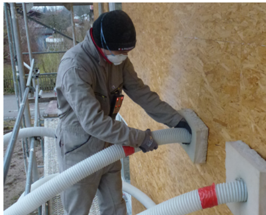
links Cellulosedämmung eingebblasen, rechts Einblasen Wärmedämmung; Fotos climacell
