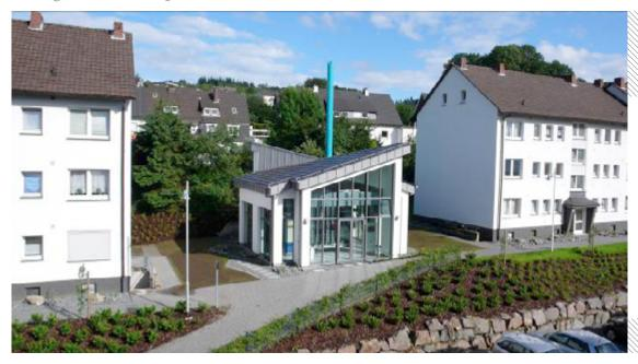
Bei der energetischen Sanierung setzt die Wohnungsgenossenschaft in Olpe auf moderne Heiztechnik, kombiniert mit fortschrittlicher Gebäudeautomation von "Kieback&Peter"; hier ein Blockheizkraftwerk zur Versorgung von 78 Wohnungen mit Nahwärme und Strom; alle Fotos WG-Olpe
