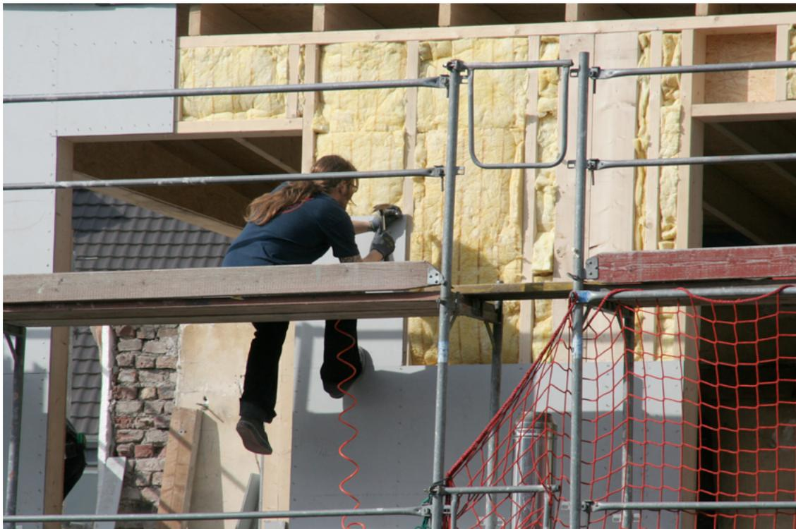
Fassadendämmung Holzunterkonstruktion; Foto Krolkiewicz
