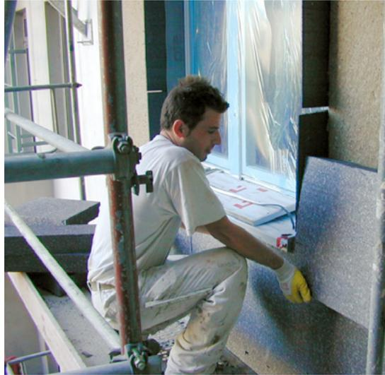
Brandriegel Fassade Fixrock 033; Foto Rockwool und WDVS Einbau der Wärmedämmschicht; Foto Krolkiewicz
