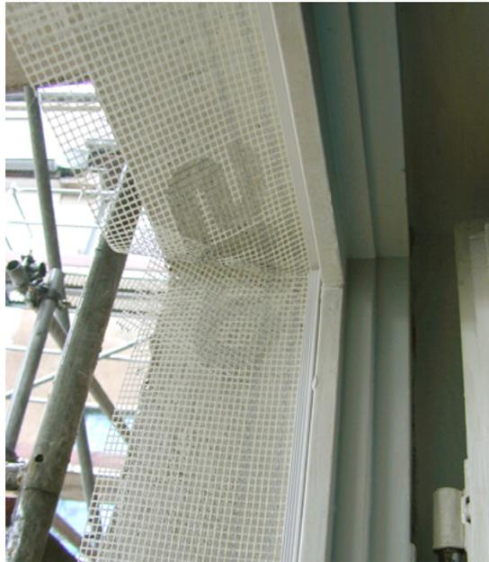
links Glasfassade mit Wärmerückgewinnung; Foto Messe glastec und rechts WDVS Armierungsgitter Fensterbereich; Foto Krolkiewicz
