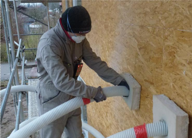
Einblasen Wärmedämmung; Foto climacell
