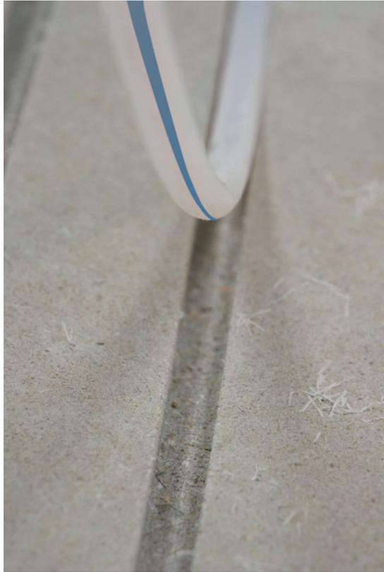
Zent-Frenger Frästechnik und Verlegung der Heizungsrohre
