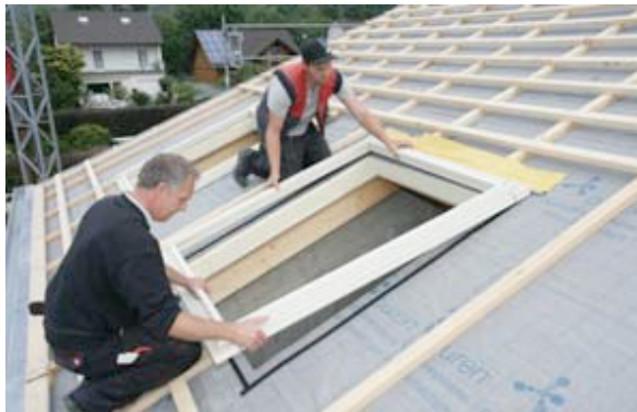
Die Dämmzargen werden auf die Kompribänder gelegt und mit der Dachkonstruktion verschraubt.
