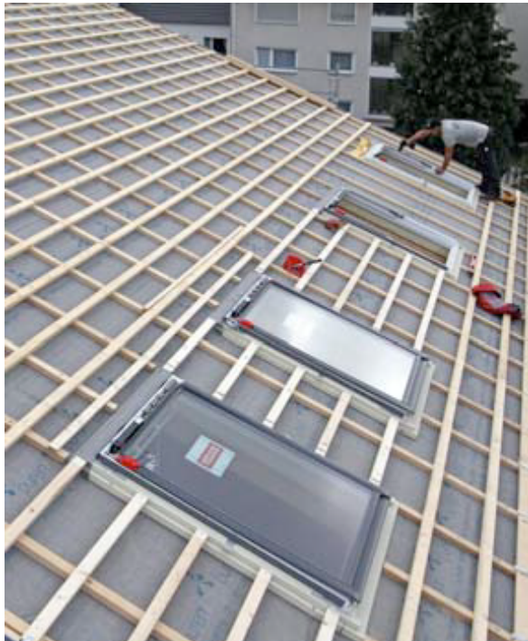
Systematische, bauphysikalisch perfekte und saubere Dachfenstermontage mit Dämmzargen
