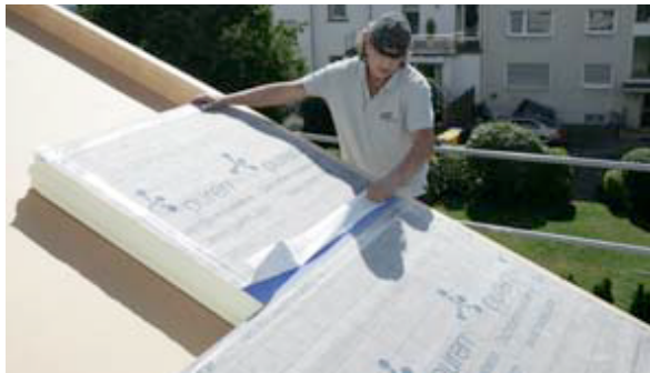
Schnelle und passgenaue Verlegung der Steildachdämmung; alle Fotos puren
