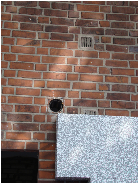
Dämmung und Backsteinfassade?
