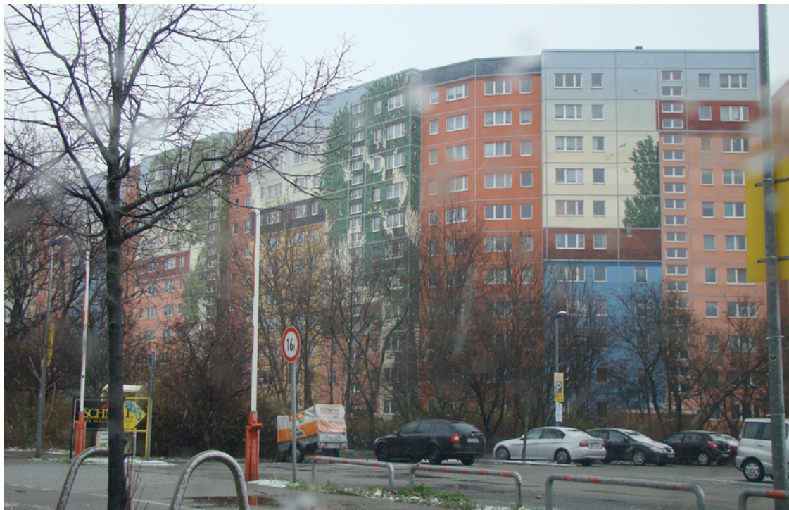
Durchsanierte Platte, Foto Warda
