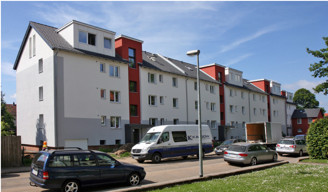
Wohnhaus in Hannover-Hainholz mit Trespa-Fassadenbekleidung; Foto meravis.
