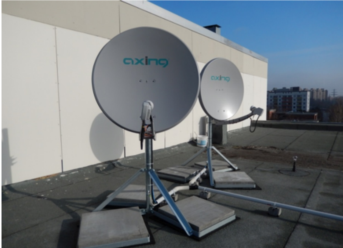
2Sat-Positionen werden per Glasfaser eingespeist Foto Buchholz
