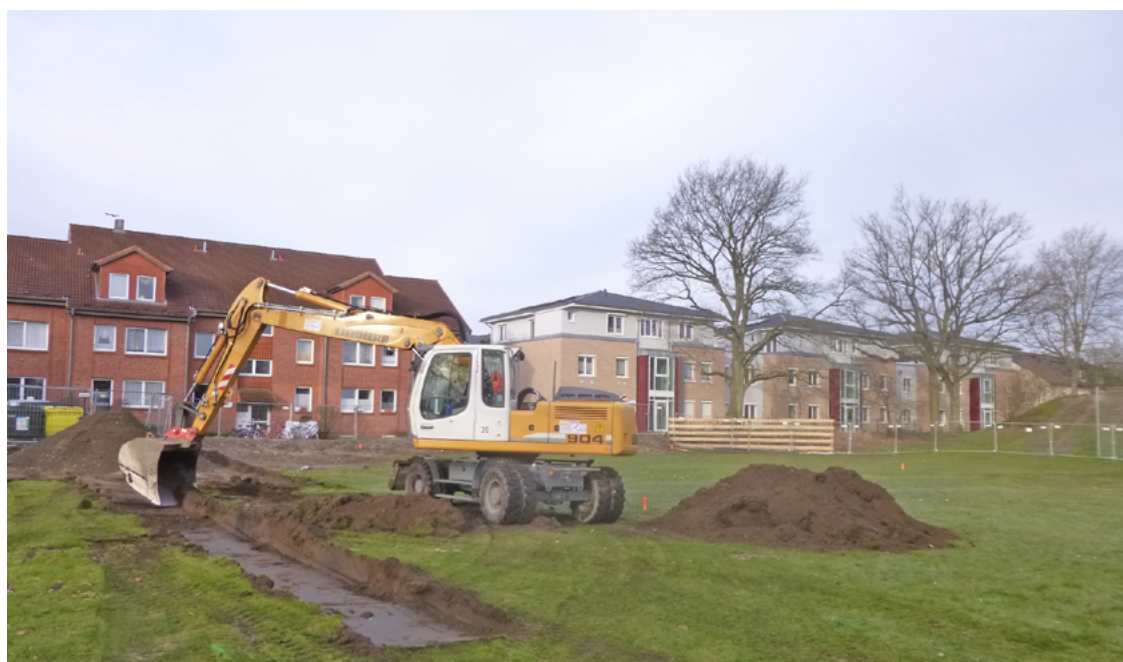
Die Arbeiten haben begonnen Foto NL
