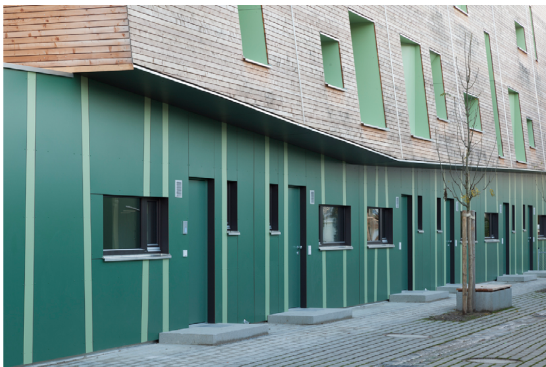
Saniertes Bestandsgebäude in der Münchner Urbanstraße; alle Fotos Südhausbau
