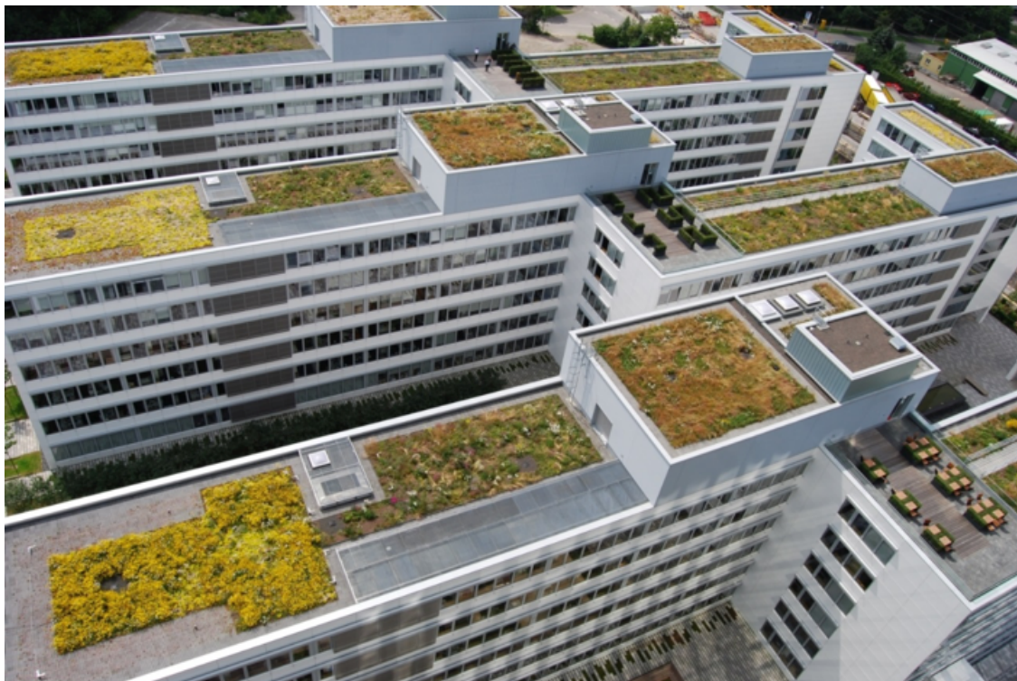
Begrünte Dächer als natürliche Regenrückhaltebecken in dicht besiedelten Städten Fotos Optigrün
