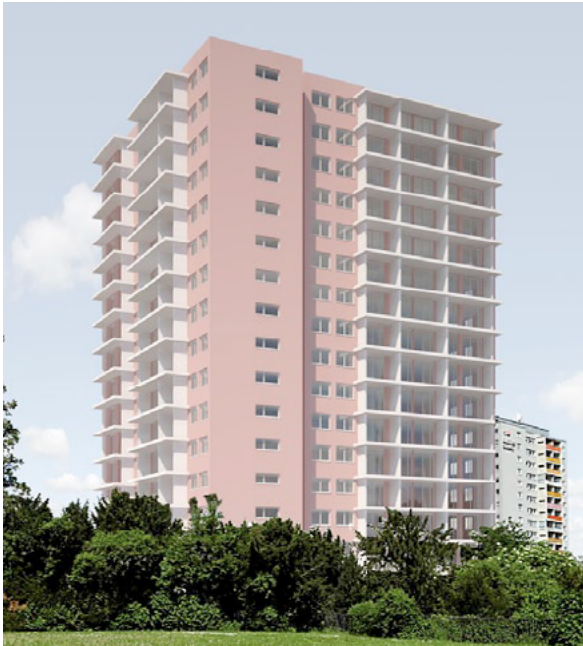
Binzengrün 34 in Weingarten-West. Das Hochhaus wird komplett modernisiert; Foto FSB
