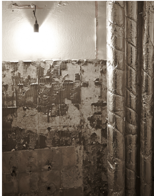
Links: Die neue Toilettenschüssel wartet auf den Einbau, rechts: Kachel sind schon entfernt, Leitungen erneuert und wenn nötig wärmeisoliert.
