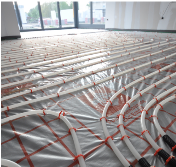
Die Installation zweier Fußbodenheizungen in der Praxis
