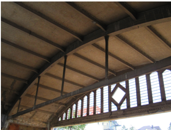
Mangels Bestandsunterlagen wurde mittels Gutachten der MPA Dresden der vorhandene Feuerwiderstand der betonummantelten Stahlzugliedern bestimmt.
