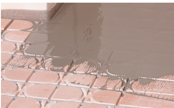
Rohrsysteme in Dämmplatte mit Nassestrich
