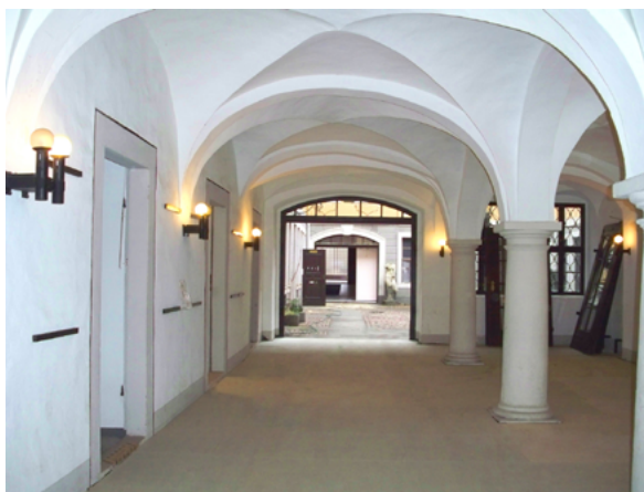
Bei der Erstellung eines Brandschutzkonzepts durch die MPA Dresden, wurde mittels Bewertungsgutachten der Feuerwiderstand der historischen Gewölbedecke beurteilt.
