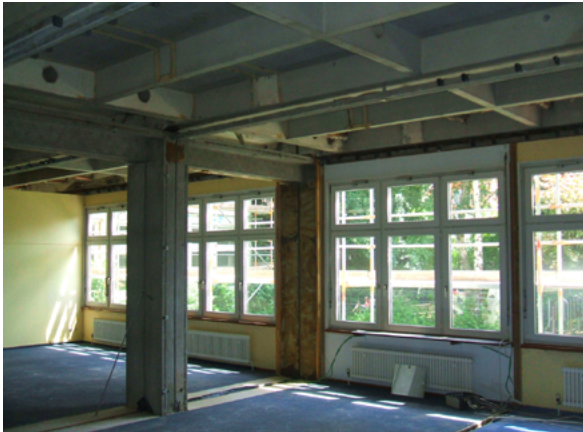
Der erforderliche Feuerwiderstand, der zur Nutzung dieser Halle notwendig ist, wurde durch eine, von der MPA Dresden vorgeschlagene, Brandschutzverkleidung der ungeschützten Stahlkonstruktion erzielt. Alle Fotos „mpa-dresden.de“
