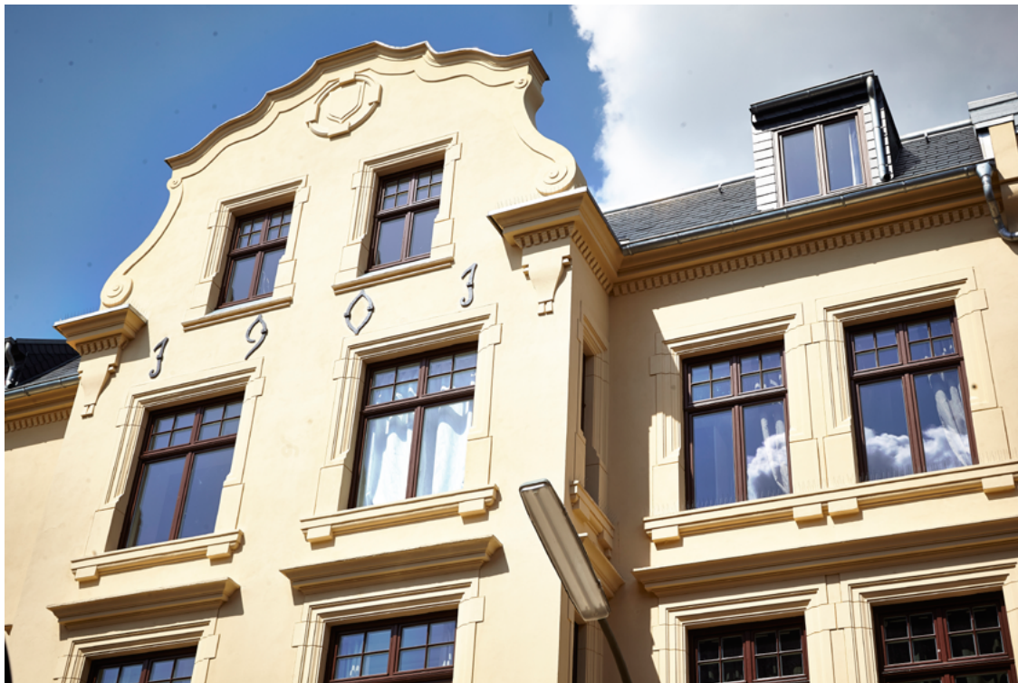
Hamburg, Braunschweiger Straße 7, Baujahr 1901, das Mehrfamilienhaus ist wieder ein Schmuckstück; alle Fotos BFGG K. Fuglsang
