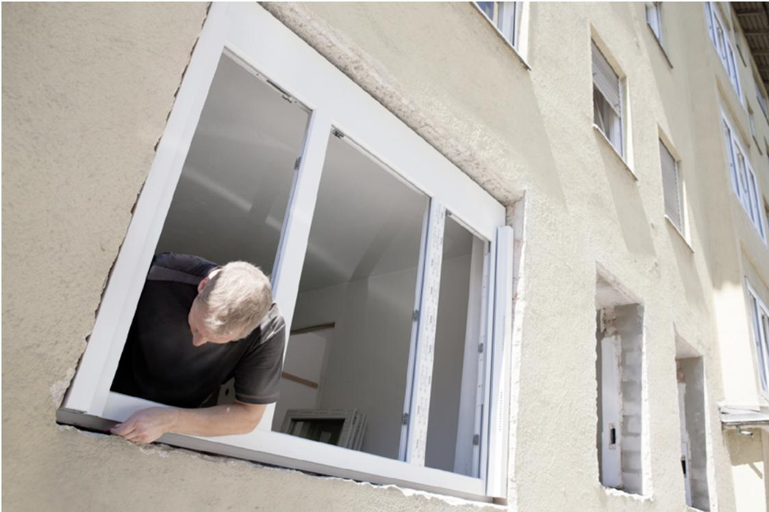
Für die Montage der Lüftungsfenster sind keine Stemmarbeiten notwendig
