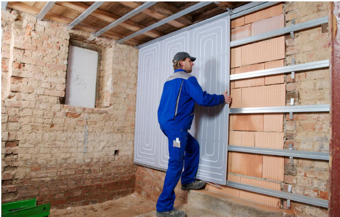
Ohne die Innendämmung lassen sich die Renovis Elemente, bspw. im Innenwandbereich, auch auf einer Holzlattung oder auf Standard CD-Profilen 60/27 installieren.
