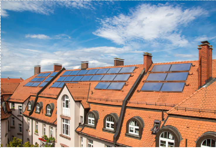
Flachkollektoren mit einer Gesamtfläche von 191 Quadratmetern und einer Leistung von circa 80 Kilowatt; Foto BVB
