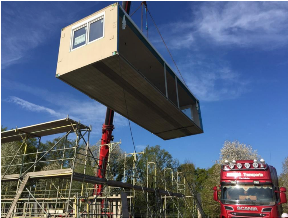
Vorgefertigte Module werden angeliefert; Foto GVE
