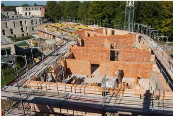
Gesundes Raumklima: Auch bei den tragenden Innenwänden setzten die Bauplaner auf Unipor-Mauerziegel. Sie regulieren dauerhaft die Feuchtigkeit im Raum und geben Schimmelbildung keine Chance. Foto: Zastrow + Zastrow, Kiel
