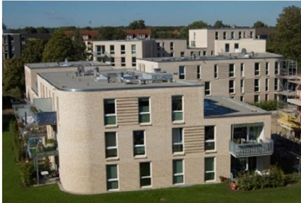
Architektonische Raffinesse im Mehrgeschossbau: Auch gestalterische Details wie abgerundete Ecken lassen sich bei der doppelschaligen Wand mit Mauerziegeln problemlos realisieren. Foto: Zastrow + Zastrow, Kiel
