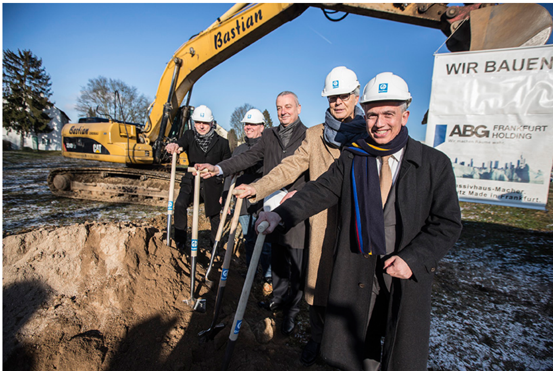
Ein Foto beim ersten Spatenstich; Foto Alex Kraus/ABG
