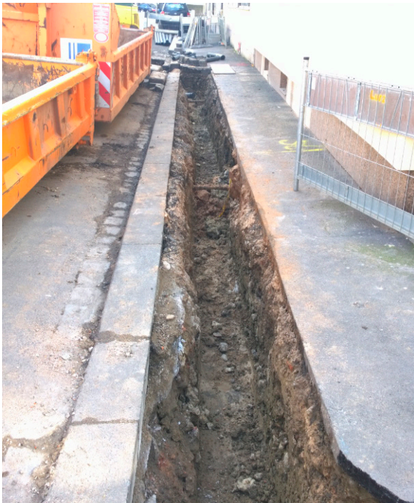
Baugruben sichern. Foto: Warda
