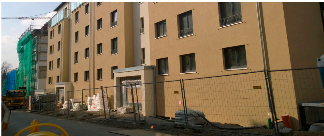
Baustellen, Material gerade an öffentlichen Straßen sichern. Foto: Warda
